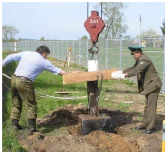
2 pav. Įrengiamas sausumos valstybės sienos ženklų centrinis (poligonometrinis) stulpelis Fig. 2. Installation of the central (poligonometric) state boundary post
